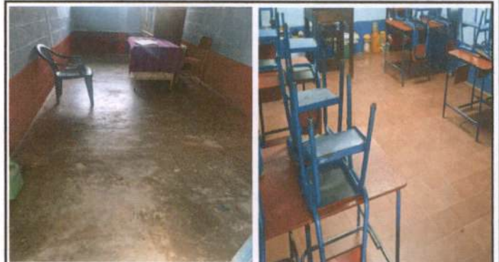
MÓDULO 2 AULAS PISO: Sustitución de piso de cemento líquido; Sustitución de piso de granito
