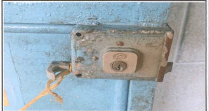
MÓDULO 2 AULAS PUERTAS DE METAL: Mantenimiento a estructura (lijado, cambio de tubo , cepillado, sujeciones, aplicación de pintura); Sustitución de chapa
