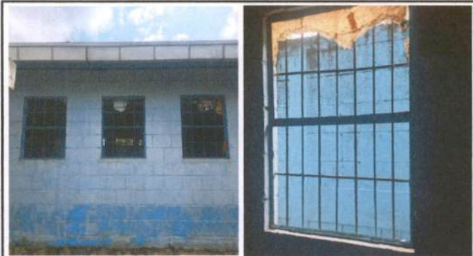
MÓDULO 2 AULAS VENTANAS: Sustitución de estructura de soporte de metal de ventana (balcones); Sustitución de ventanas de madera por PVC
