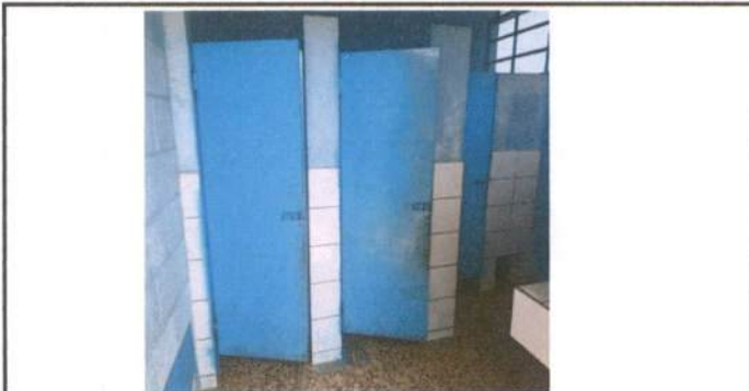
MÓDULO 3 SERVICIOS SANITARIOS: PUERTAS DE METAL: Mantenimiento a estructura (lijado, cepillado y aplicación de pintura);
