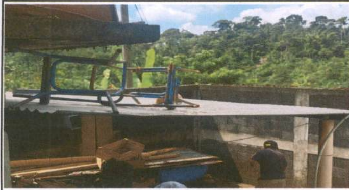
MÓDULO 1 COCINA : CUBIERTA DE LÁMINA: Sustitución de lámina, por lámina troquelada aluzinc calibre 26; ESTRUCTURA DE TECHA: Sustitución de estructura de soporte de metal
